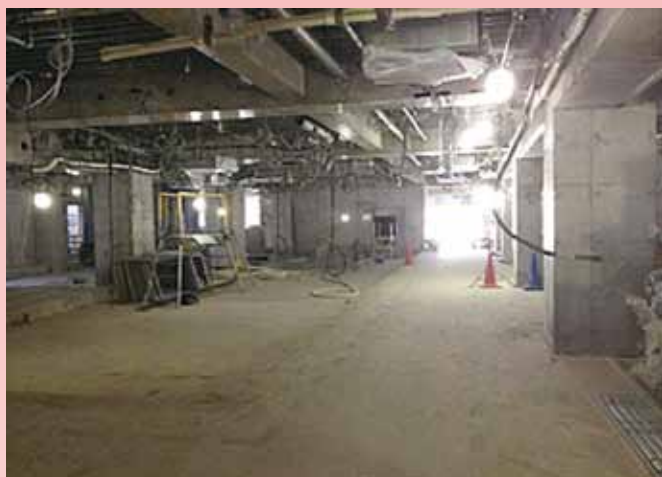
1階 検査室・レントゲン室付近
